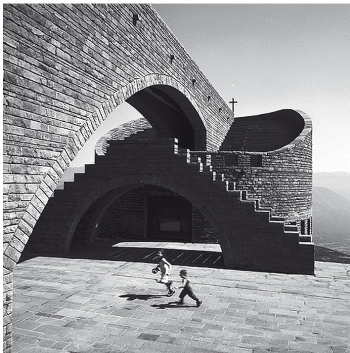
Поклонническа църква „Санта Мария дели Анжели“ в Монте Тамаро (на 1600 метра надморска височина в Алпите) от арх. Марио Бота. Ктитор е собственикът на близката въжена линия Еджидио Катано, а резултатът е пореден шедьовър на Бота – чужд на традиционните схеми, но напълно в духа на мястото.
